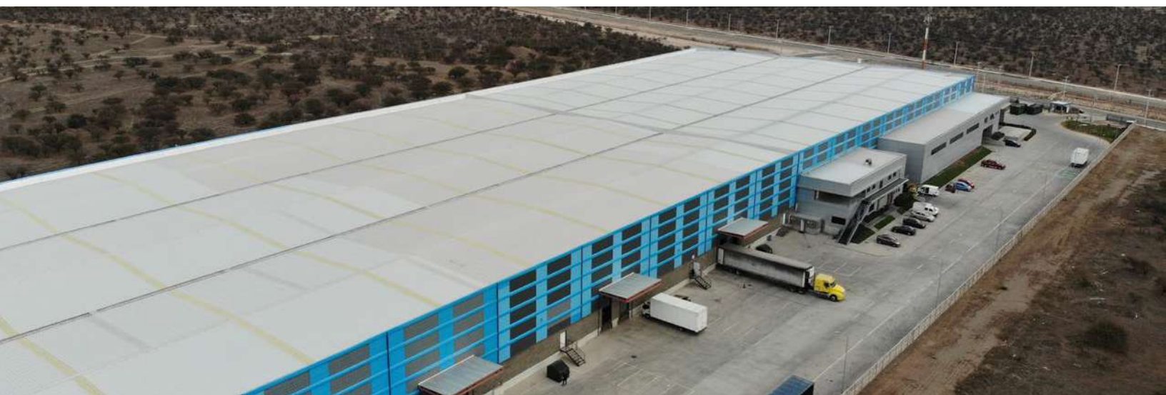
VISTA DE LA FÁBRICA
